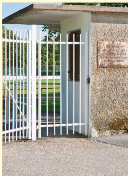
Die Sanierung des Sportplatzes wurde schon von Bürgermeister Nießl versprochen - jetzt haben wieder einmal andere Projekte Vorrang.
